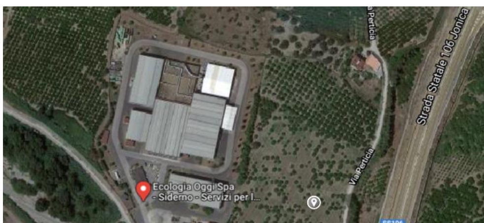
Figura 1 - L'impianto di Siderno.
