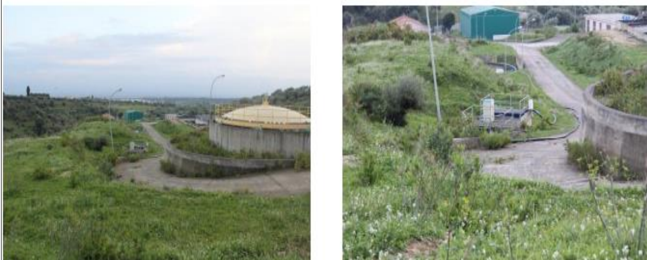
Fig. 2 - Depuratore consortile di Misterbianco
