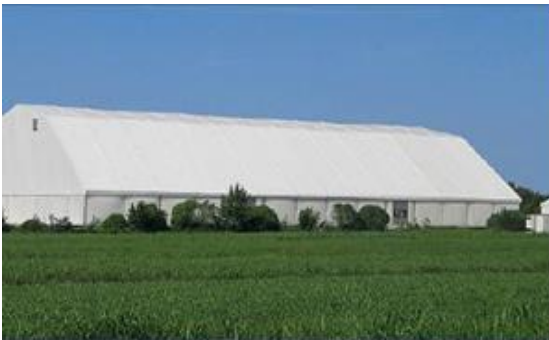
Figura 5 – Tensostruttura poligonale di confinamento (montata sul capannone in lavorazione, smontata alla conclusione della demolizione e trasferita su altro capannone)
